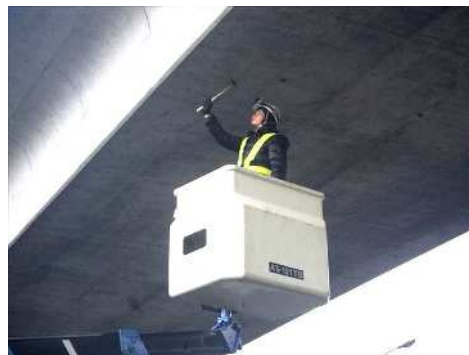
b) 打音点検の状況
