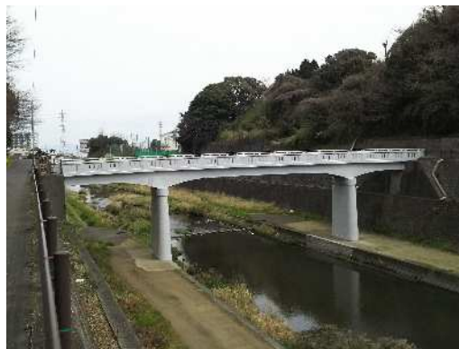
写真 3.3 修繕後の状況
