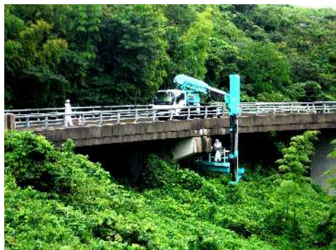
(a) 橋梁点検車による点検状況
