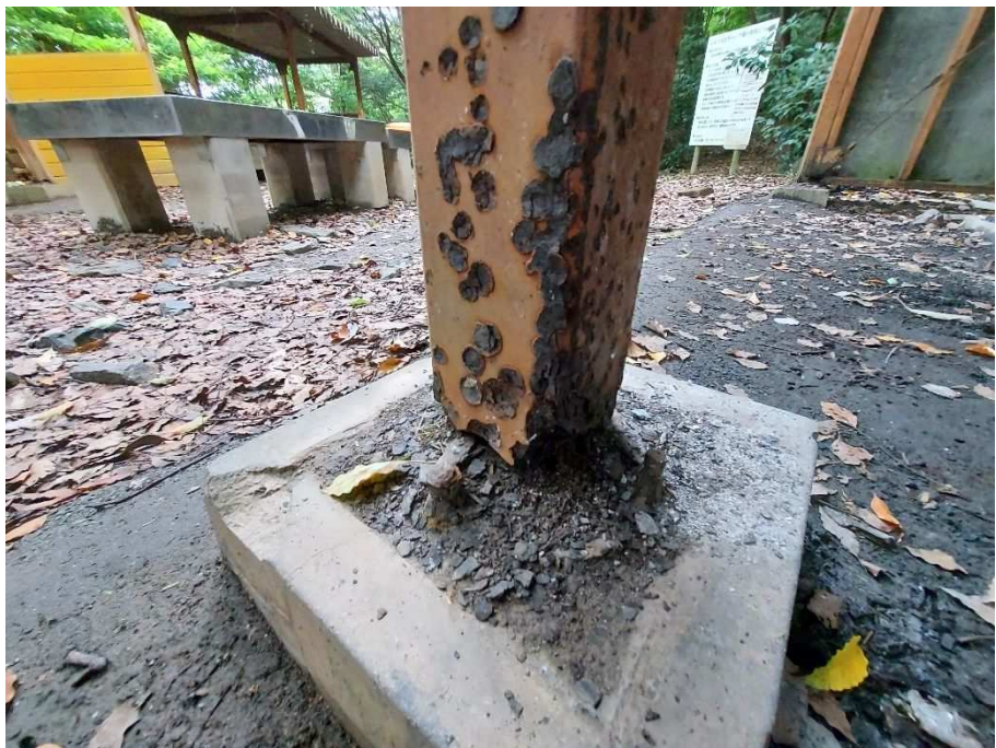
かまど場(屋根付き) 屋根の柱の付け根部分
