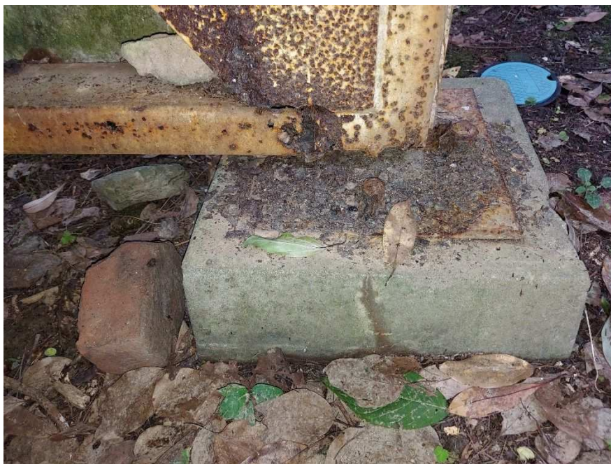
洗面所(屋根付き) 屋根の柱の付け根部分
