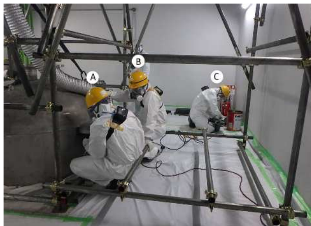
写真3 タンク切断作業時の個人サンプラー実施状況
