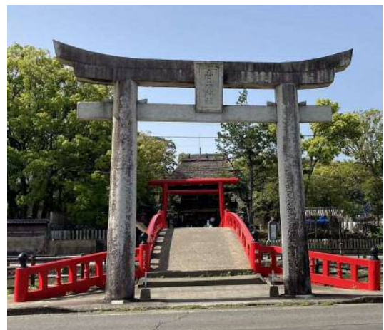
被災した橋の欄干の修復が完了
