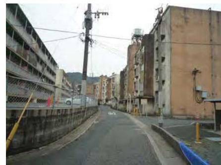
G. 敷地内道路
