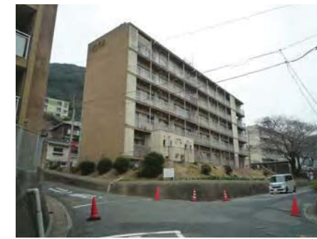
L. 34号棟（南側法面）
