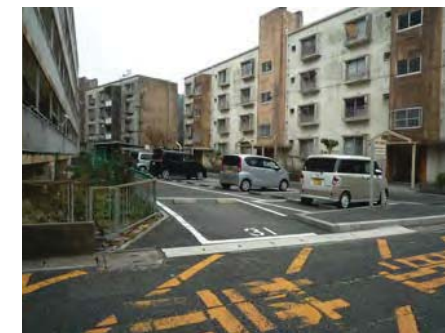
O. 22号棟南側駐車場
