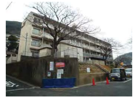
Q. 33号棟（南側法面）
