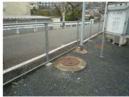
B. 消火水槽
