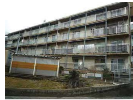
I. 32号棟（南側法面）
