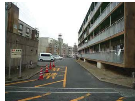
J. 21号棟南側駐車場
