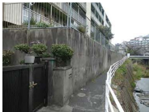
西側大川沿い通路
