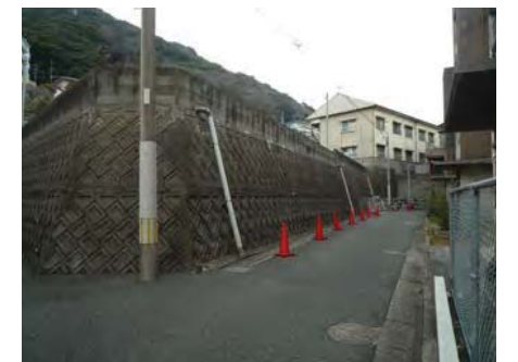
T. 31号棟北側擁壁
