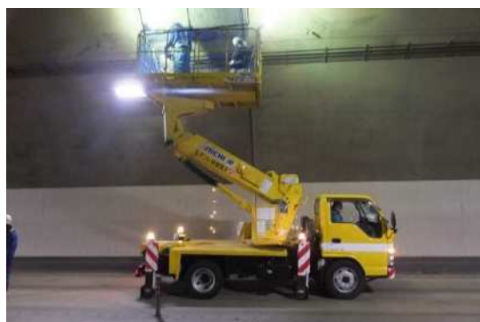
(a)高所作業車による点検状況
