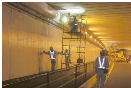
(b)移動足場による点検状況
