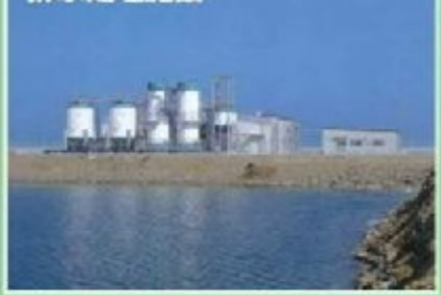
排水処理施設
