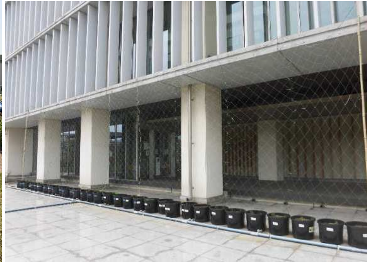
令和4年5月10日 ネット設置
