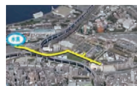
水素パイプライン
