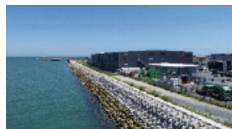
図 2-17 護岸整備(新門司地区)
