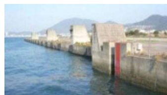
図 2-18 耐震強化岸壁の整備(砂津地区)
