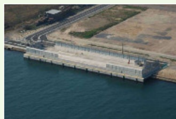
響灘リサイクルポート岸壁
