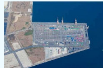
ひびきコンテナターミナル
