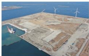
響灘地区港湾(整備実施中)
