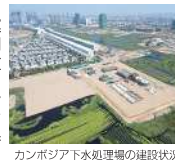
カンボジア下水処理場の建設状況
