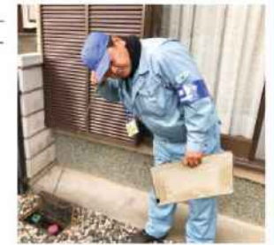
漏水調査の様子
