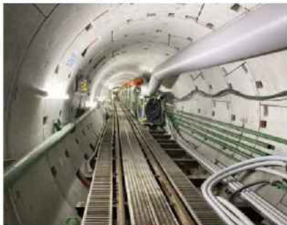
雨水貯留管(小倉北区昭和町)
