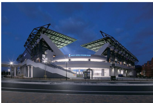
図 7-10 PFI 事業により整備した運動施設(ミクニワールドスタジアム北九州)
