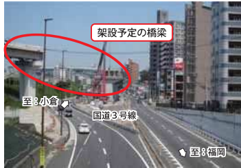
▲国道 3 号から小倉方面を望む（現在の整備状況）
