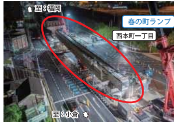
架設時の状況（西本町一丁目交差点をまたぐ橋梁）
