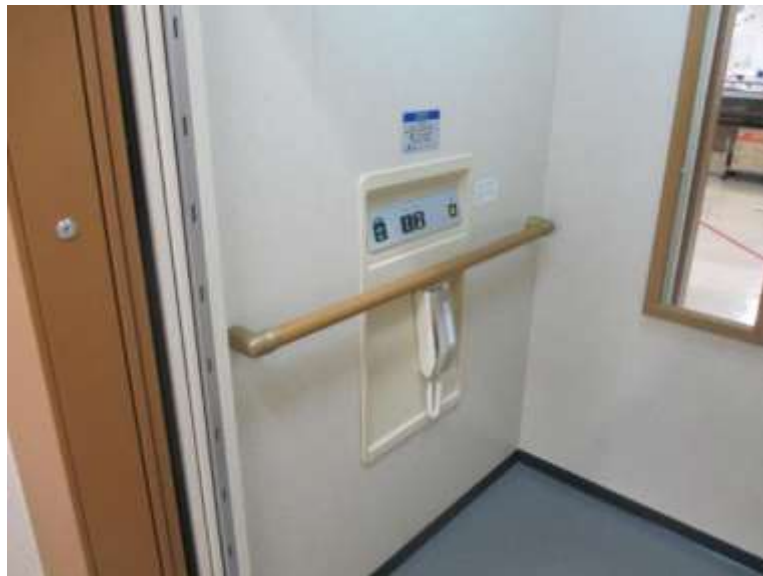
エレベーター
