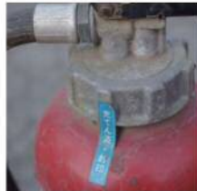
× キャップの劣化
