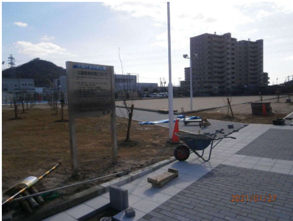
解体・復旧される平成ヶ浜中央公園応急仮設住宅跡
