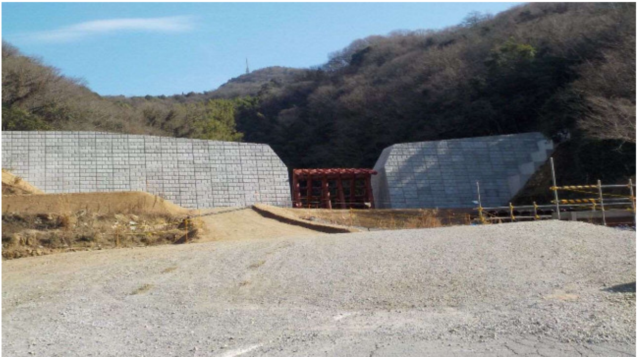
【総頭川上流砂防堰堤全貌】
