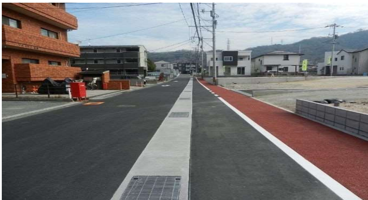
【被災した宅地（水路右側）の一部を町道拡幅用地として譲り受けて復旧】
