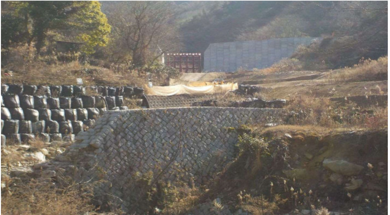
【砂防堰堤の新旧 手前が被災した旧堰堤、奥が新たな堰堤】
