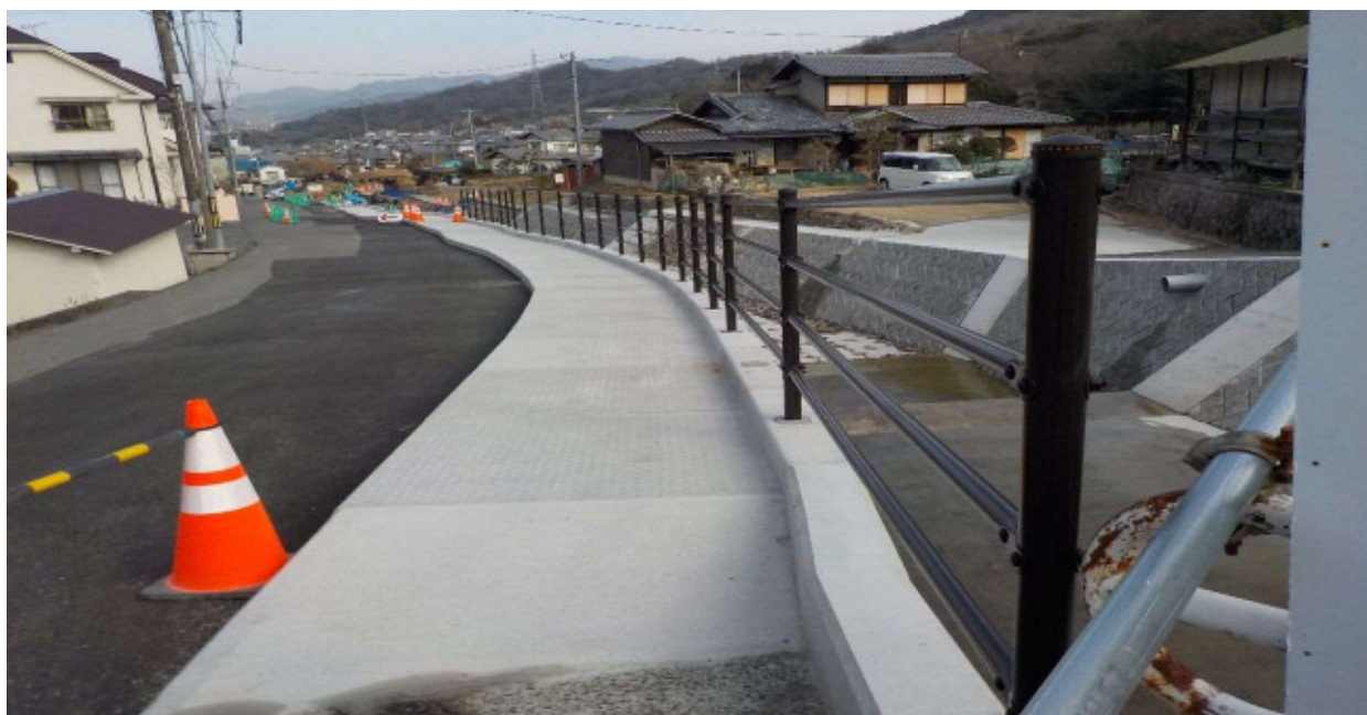
【張出歩道復旧状況】
