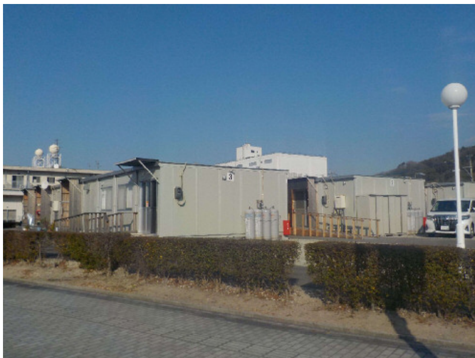
供給延長で集約された平成ヶ浜東公園応急仮設住宅
