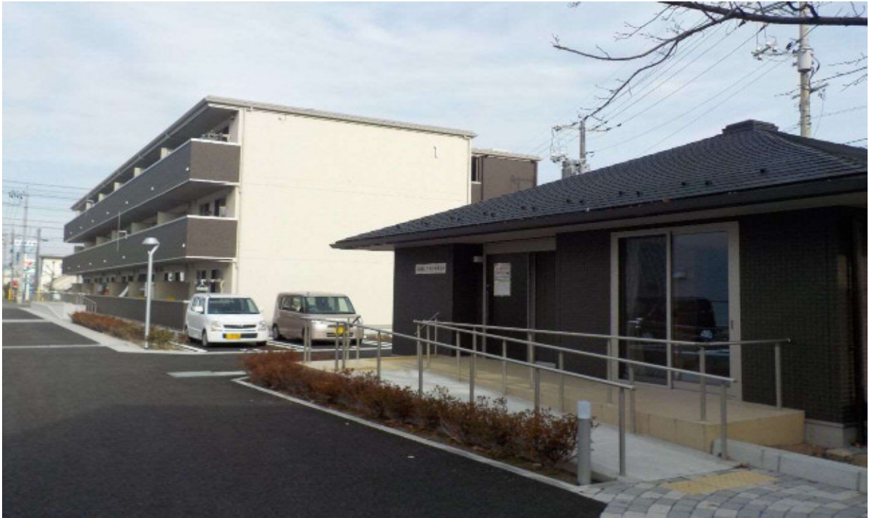
【復興住宅全貌手前は集会所】
