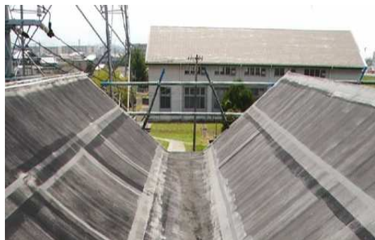
ポンプ棟屋上防水前
