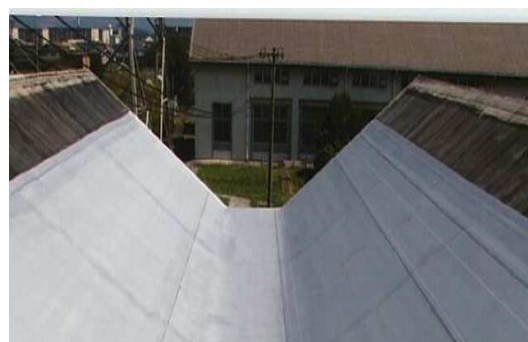
ポンプ棟屋上防水後
