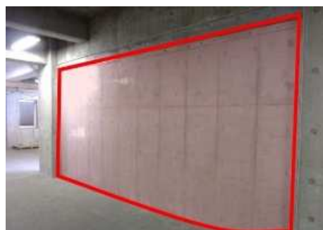
補強後（中空部に耐震壁を設置）
