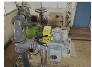
ポンプ設備更新後
