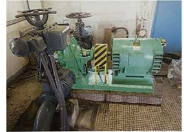
ポンプ設備更新前
