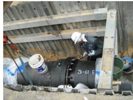
耐震管布設状況
