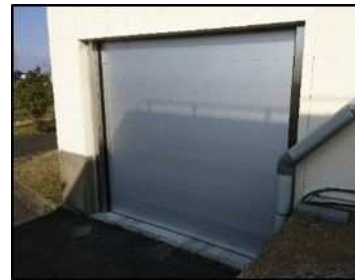
防水扉（防水シャッター）の整備状況
