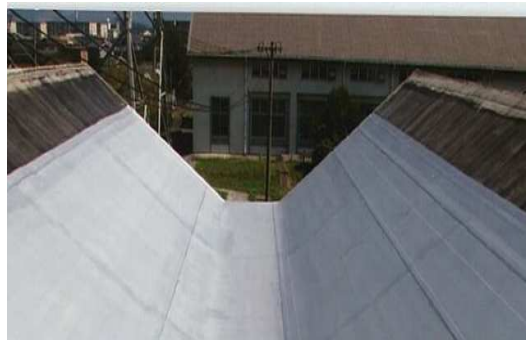
ポンプ棟屋上防水後
