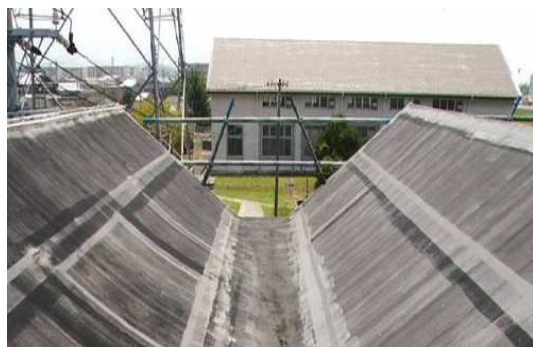
ポンプ棟屋上防水前
