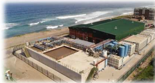
海淡・下水再利用統合システム (南アフリカ共和国・ダーバン市)
