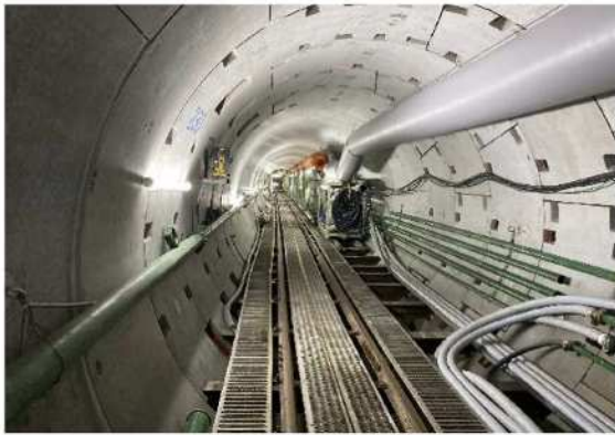
整備中の昭和町雨水貯留管
