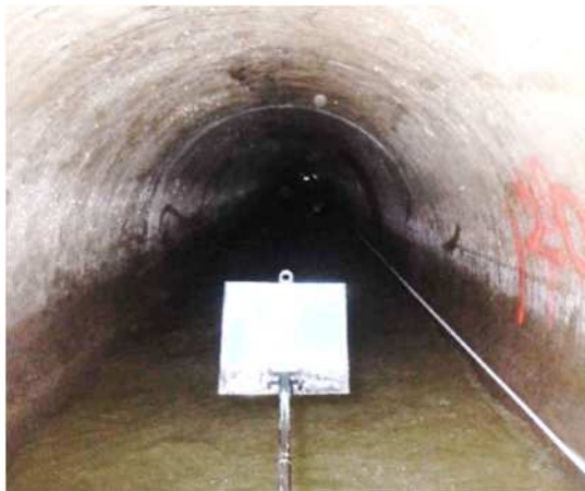
耐震化前の下水道管渠
