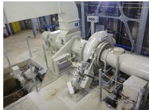
油木発電所(780kW)
