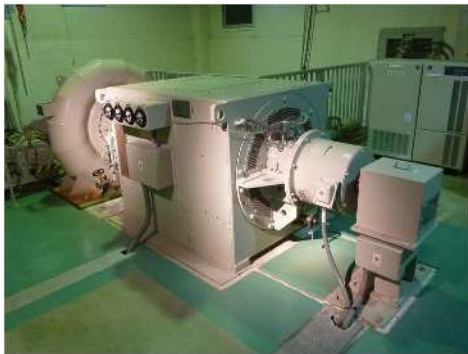
ます湊発電所(520kW)
