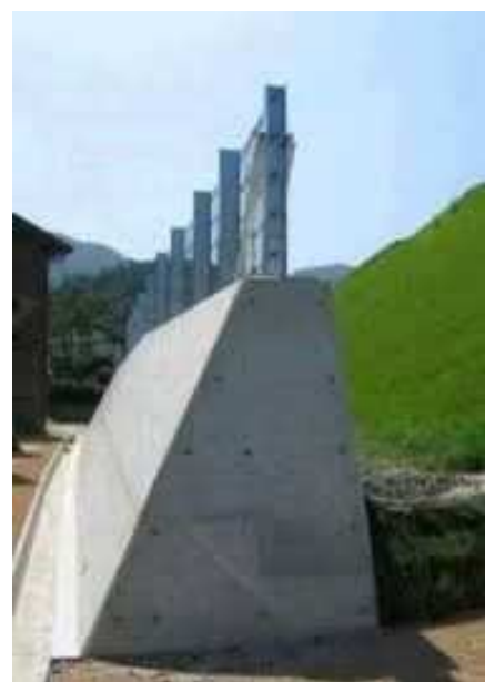
土砂災害対策の事例
