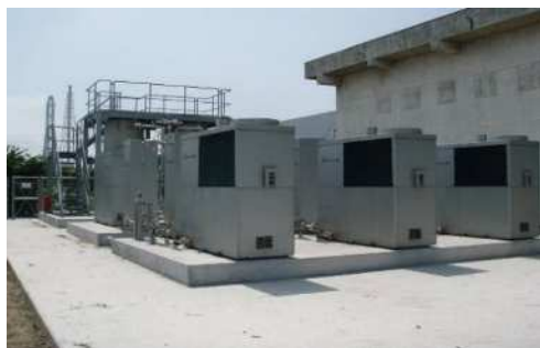
バイオガス発電*(日明浄化センター)
