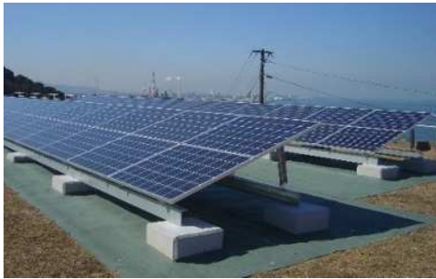
太陽光発電(二島配水池)
