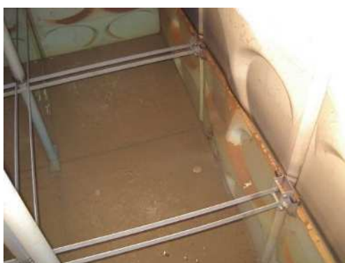
管理が不十分な小規模貯水槽(民間施設)
