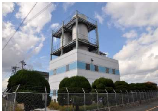
活性炭注入設備
