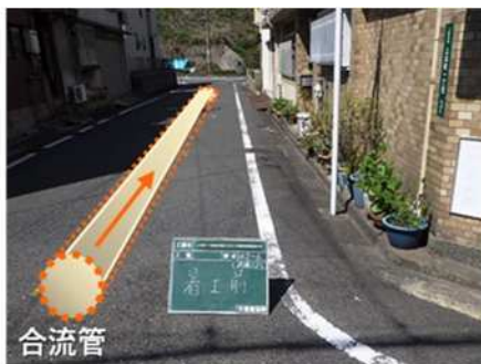
分流化(施工前)
