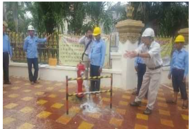
漏水対策指導
