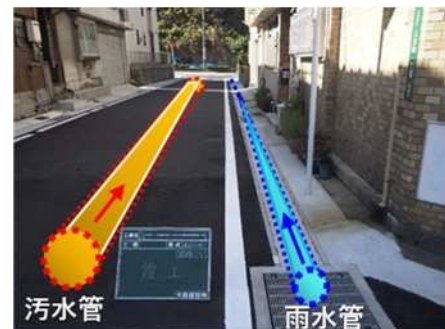
分流化(施工後)
