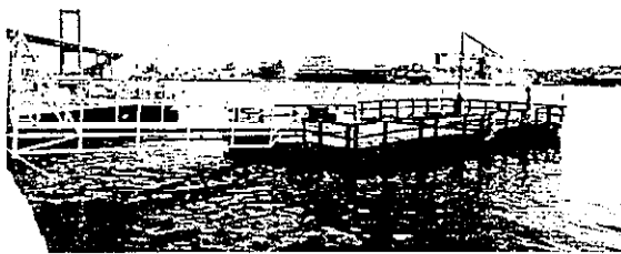
図5 洞海湾に設置した環境修復実証実験施設
