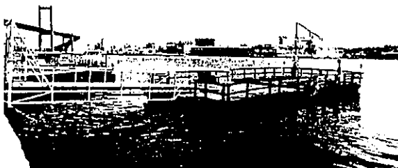
図5 洞海湾に設置した環境修復実証実験施設
