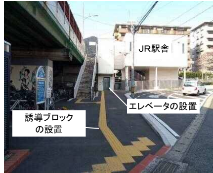
▲安部山公園駅バリアフリー化（南側広場）
