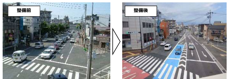
▲清水交差点の整備前・整備後の状況
