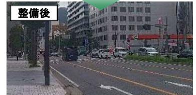
▲小文字歩道橋撤去（小倉北区）
