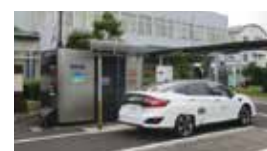
スマート水素ステーション
