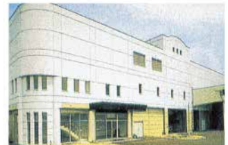
日明工場粗大ごみ資源化センター
