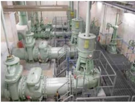
下水管の途中にポンプ場をつくって、よごれた水をくみ上げ、浄化センターへ流れるようにしています。
