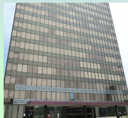
北九州市役所本庁舎
