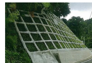
簡易吹付法枠
