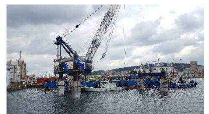
いよいよ工事が始まりました。
