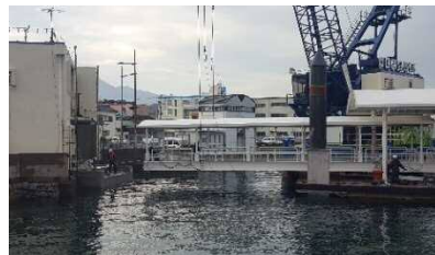
新生浮栈橋誕生間近です。連絡橋を陸とつなげます。
