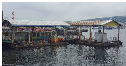
旧戸畑浮栈橋です。左側の浮栈橋は大正10年から活躍したんですよ。
