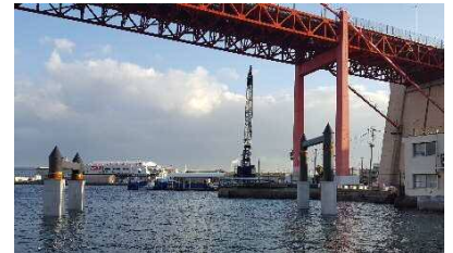
着々と工事が進んでいます。
