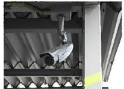
駐車場の設置例
