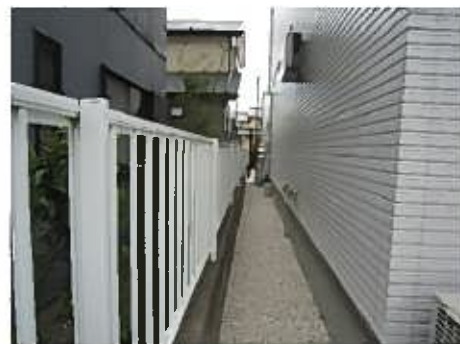
玉砂利の敷設
