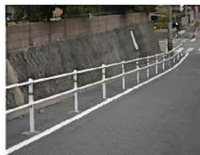
ガードパイプで歩道と車道を分離した道路
