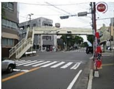
歩道橋（撤去前）
