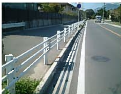
ガードパイプで歩道と車道を分離した道路
