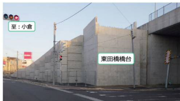
▲完成した橋台
