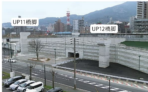
▲完成した橋脚
