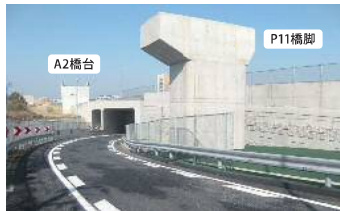
▲完了した橋台と橋脚
