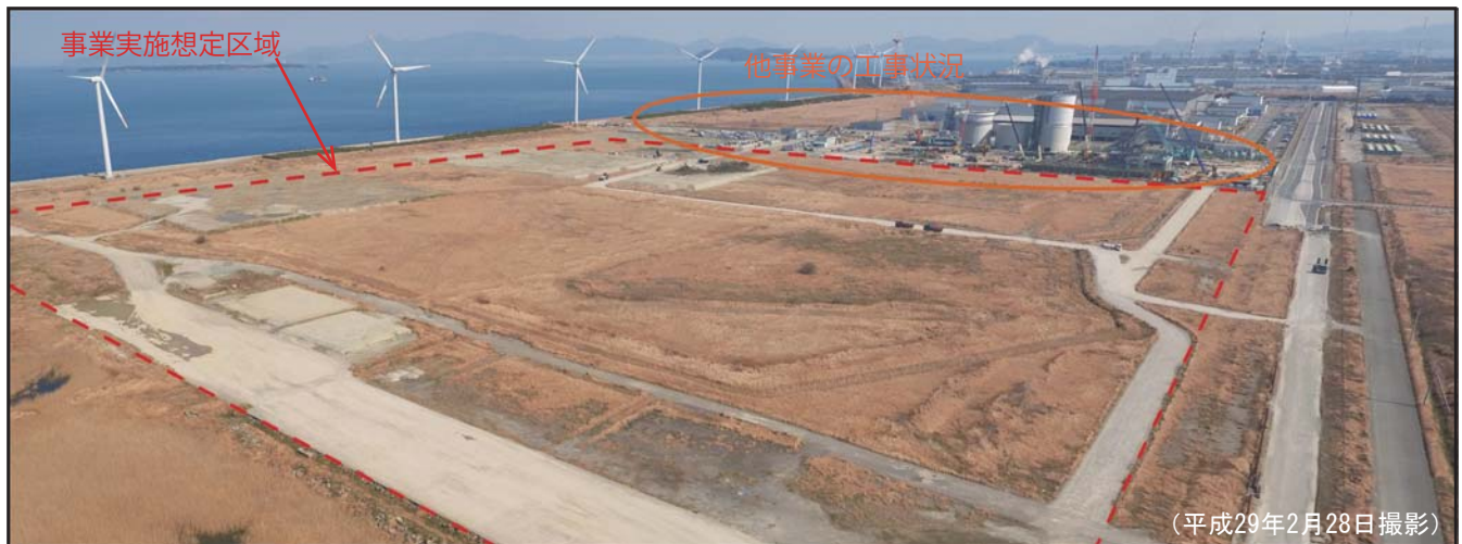
▲事業実施想定区域付近の状況(南西側から撮影)
