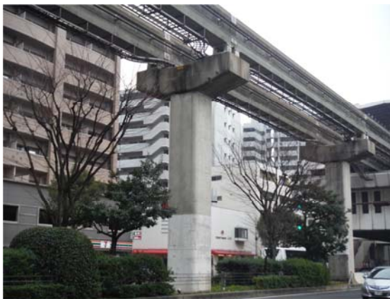
RC 支柱 全景
