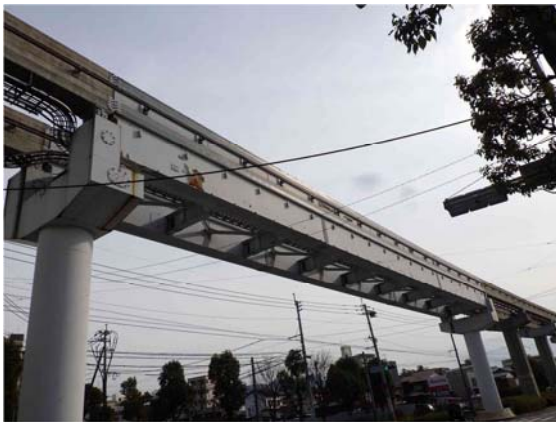
鋼軌道桁 全景
