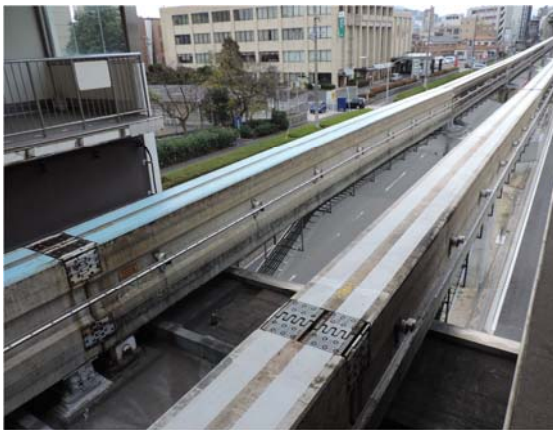
PC 軌道桁 全景
