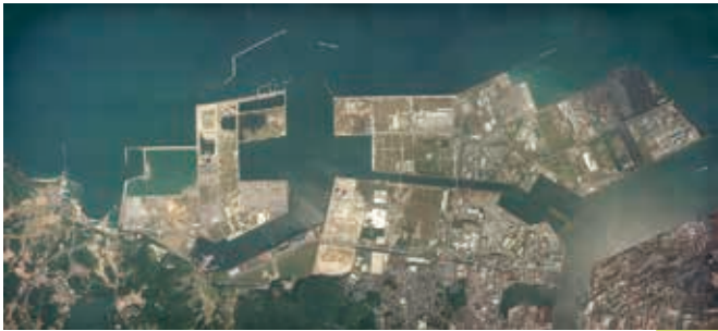
響灘西地区廃棄物処分場全景（平成25年9月）
