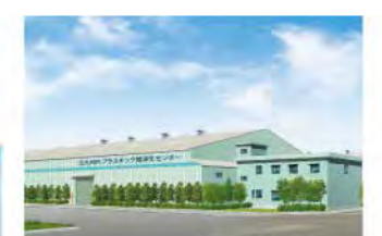
北九州市プラスチック資源化センター
