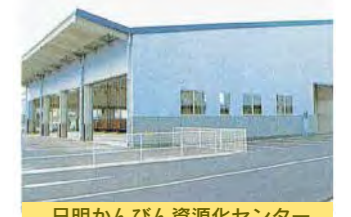
日明かんびん資源化センター
