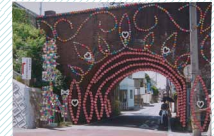
前田 季瑠乃 / 折尾のレンガトンネル (八幡西区折尾 旧西鉄煉瓦橋梁)
