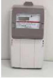
現地設置のスマートメータ
