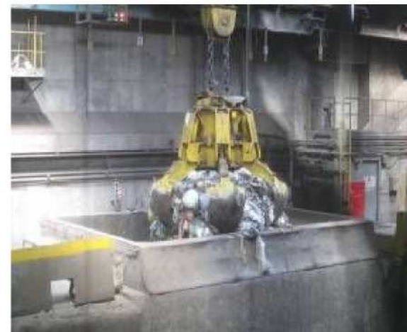
③(混合ごみ 焼却炉投入)
