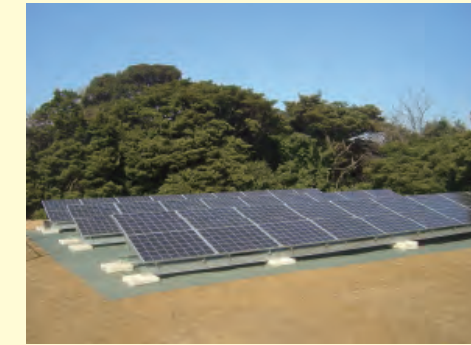
水道局配水池
