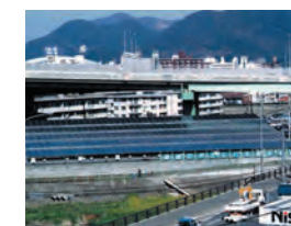
太陽光発電 ・紫川水源地 (150kW)
