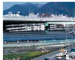
太陽光発電 ・紫川水源地 (150kw)
