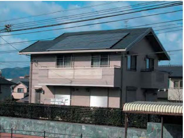
住宅用太陽光発電システム
