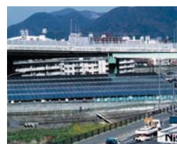
太陽光発電 ・紫川水源地 (150kw)
