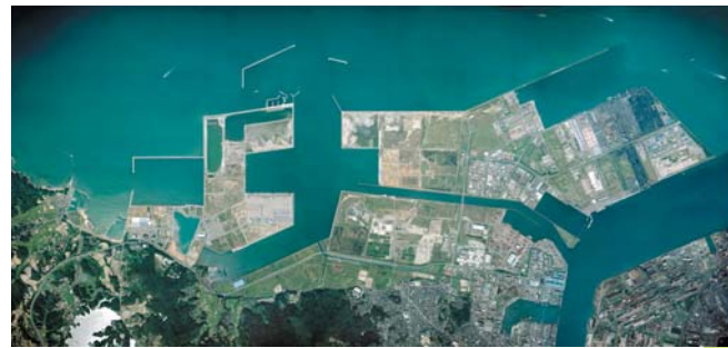
響灘西地区廃棄物処分場全景(平成18年9月)
